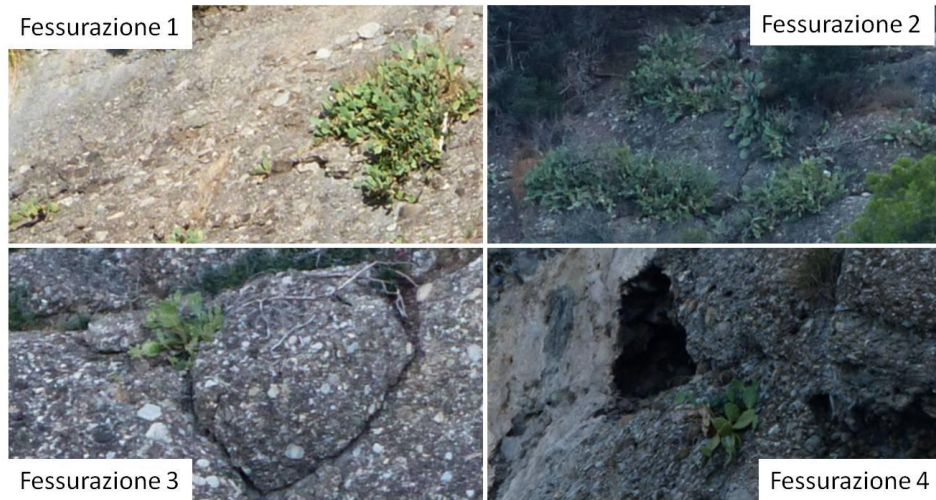
Figura 4. Livelli di fessurazione: 1 - assenza di fessure evidenti e profonde; 2 - presenza di fessure evidenti; 3 - presenza di fessure evidenti e profonde; 4 - presenza di cavità.
