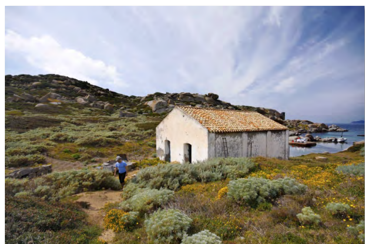
Fonte: Comune di Villasimius Cala di Ponente: il principale punto d'approdo con annesso fabbricato d'appoggio
