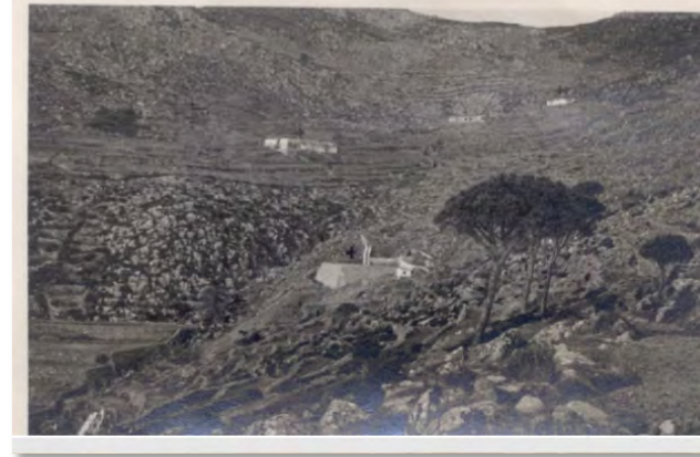
Capraia – Réservoirs de collecte de l'eau zone Aghiale
