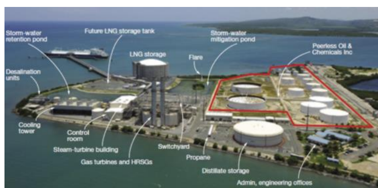
Figure 51: Projet EcoEléctrica sur l'île de Porto Rico; Terminal GNL couplé à une centrale électrique à turbine à gaz à cycle combiné
