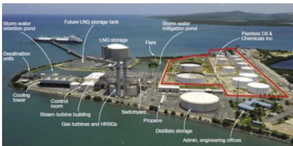
Figure 45: Projet EcoEléctrica sur l'île de Porto Rico ; terminal GNL couplé à une centrale électrique à turbine à gaz à cycle combiné
