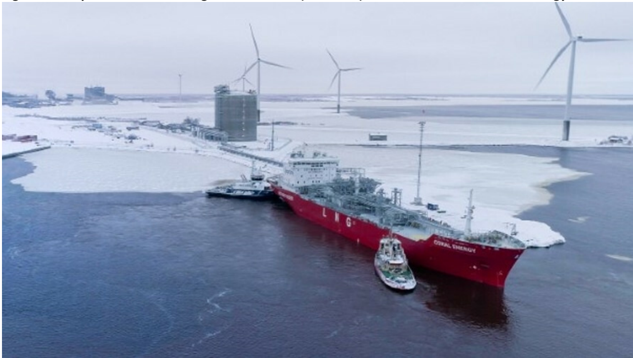
Figura 11. Deposito costiero Manga LNG – Tornio (Finlandia) e metaniera SSLNG “Coral Energy”
