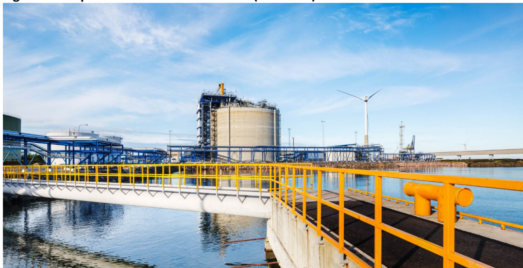
Figura 12. Deposito costiero Gasum – Pori (Finlandia)
