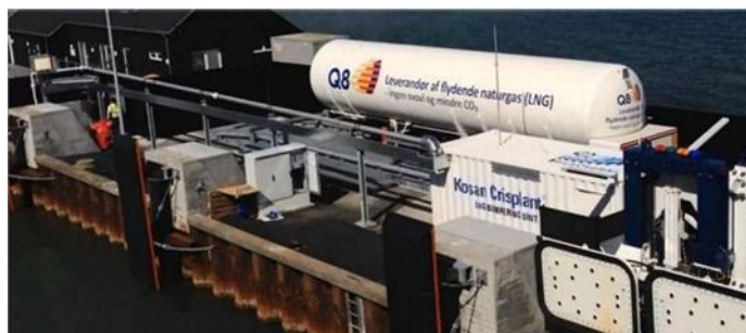
Figure 84: Exemple de système "Citerne sur skid"
