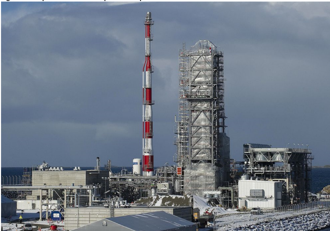
Figura 15. Deposito costiero e impianto di liquefazione Gasum - Risavika
