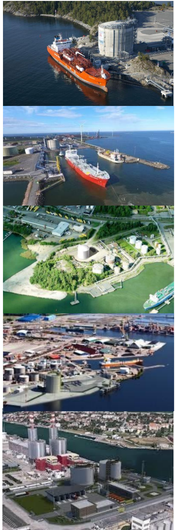
FIGURE 12 - TERMINAL GNL (DE HAUT EN BAS): NIJMEGEN, SUÈDE, PORI, FINLANDE, PROJET TURKU, FINLANDE, PROJET OXELUND, SUÈDE, PROJET RAVENNA, ITALIE
