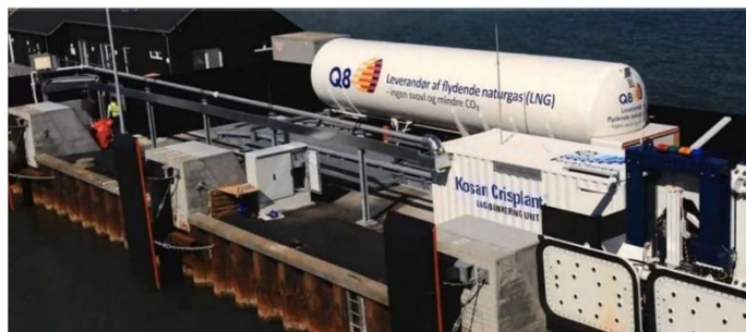
FIGURE 7 - RÉSERVOIR DE SOUTAGE À SAMSOE (DANEMARK)
