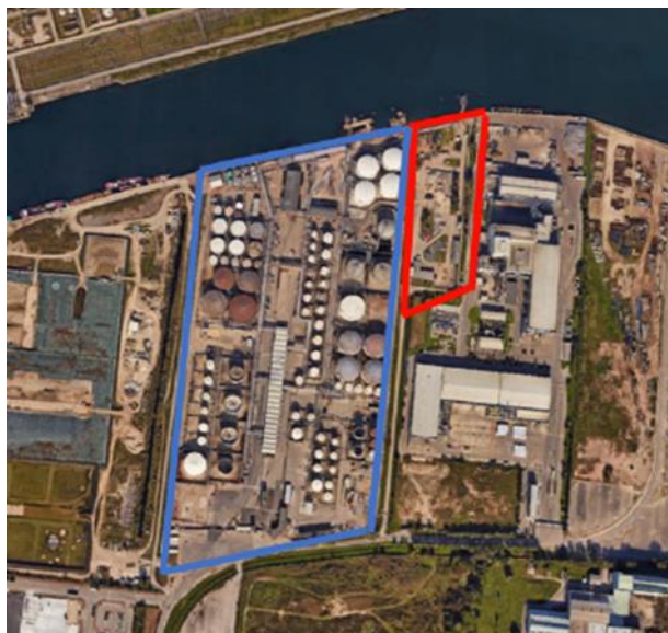
Figure 36. Zone chargée à la réalisation du dépôt de GNL Venice LNG
