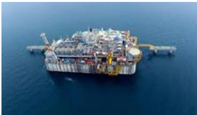
Figure 41. Le terminal de regazéification Adriatic LNG
