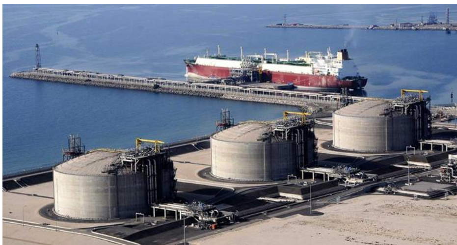
Figure 33. Terminal méthanier de Fos-Cavaou
