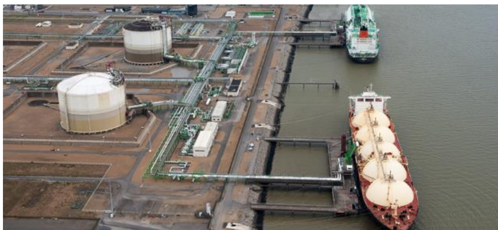
Figure 44. Opération de transbordement de GNL entre deux méthaniers dans le terminal de Montoir-de-Bretagne
