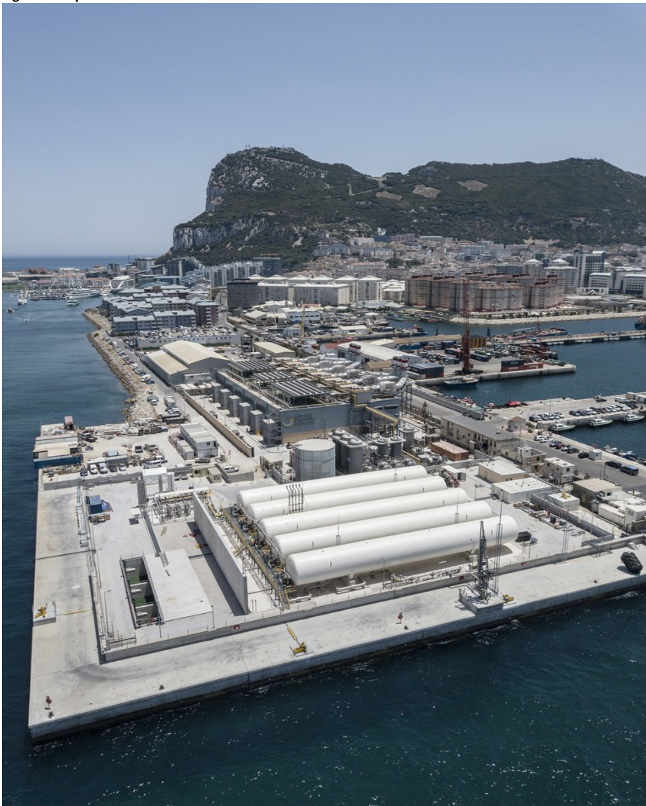
Figura 9. Deposito costiero Gasnor – Porto di Gibilterra
