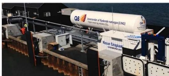
Figura 84: Esempio di sistema "Cisterna su skid"
