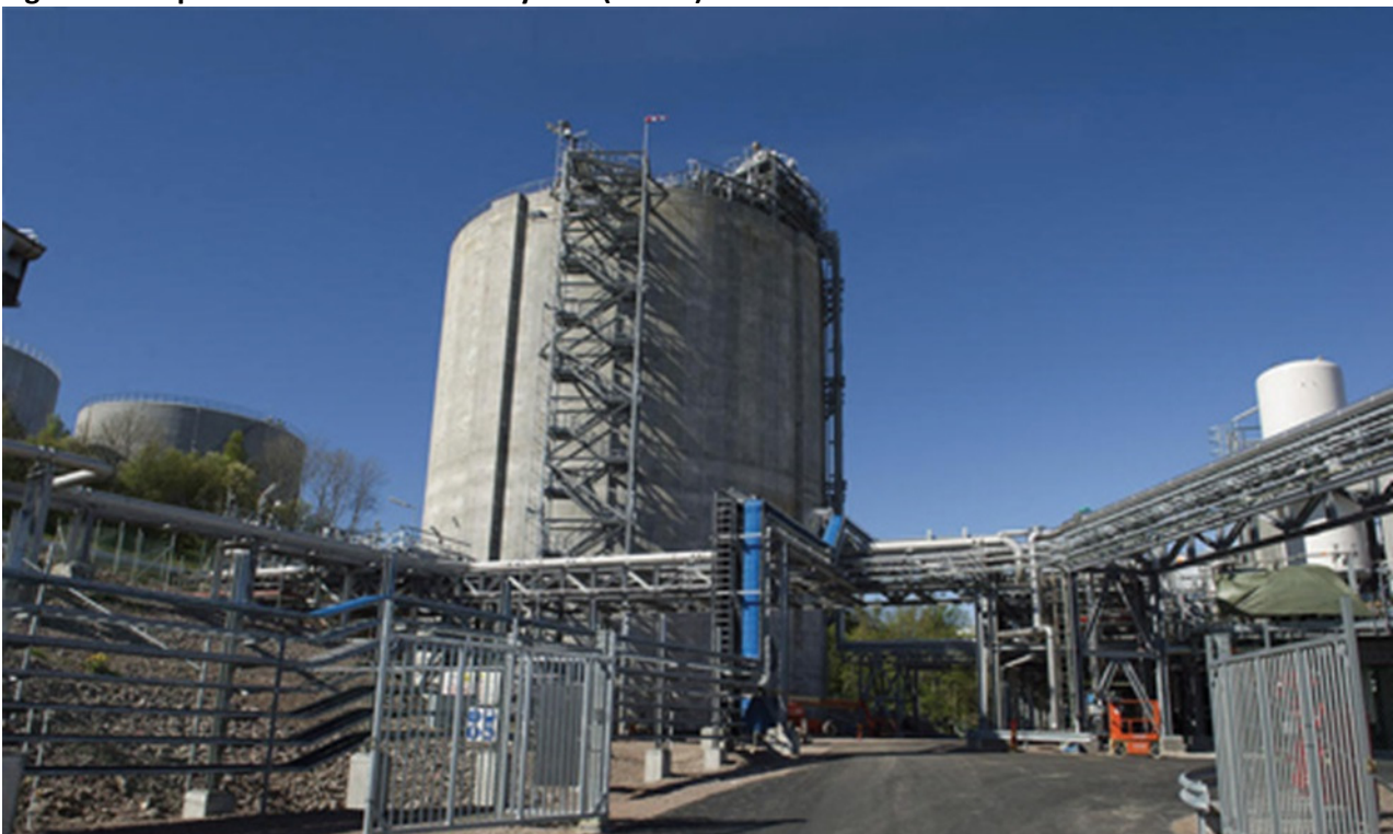
Figura 13. Deposito costiero Gasum – Lysekil (Svezia)
