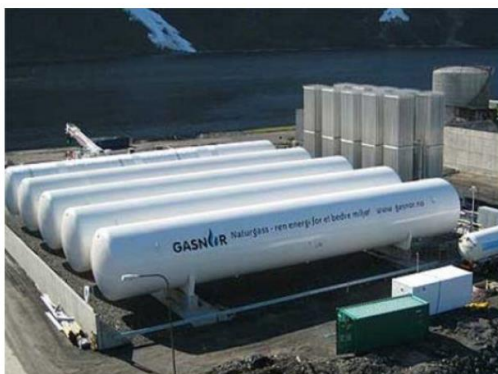
Figura 10. Esempi di serbatoi in pressione (sx) e atmosferici (dx) (9)
