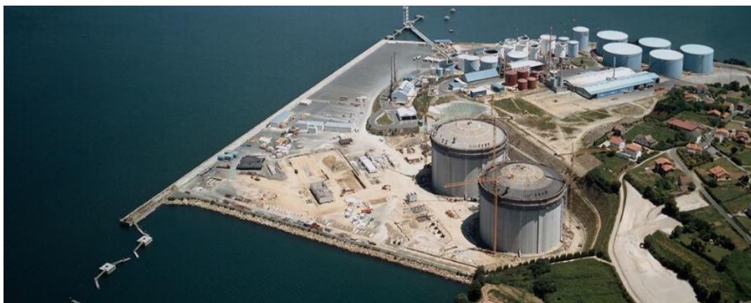
Figura 53. Mugardos Lng Terminal
