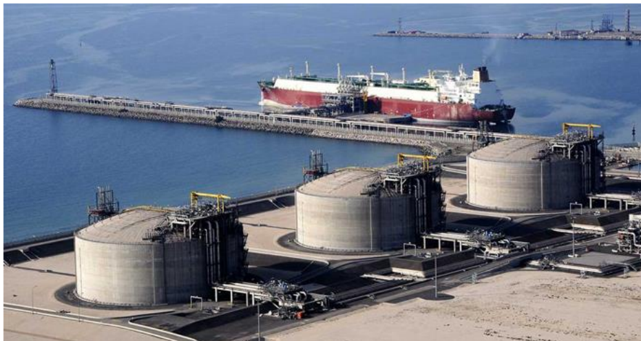
Figura 33. Terminal méthanier de Fos-Cavaou
