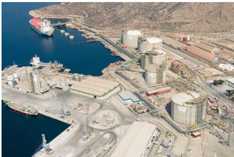
Figura 51. Cartagena LNG Terminal
