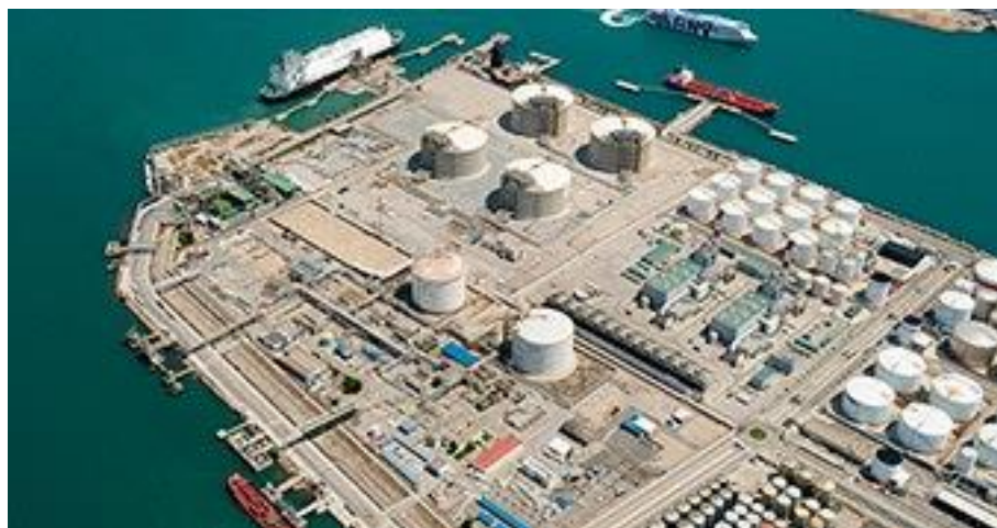
Figura 49. Barcellona Lng Terminal
