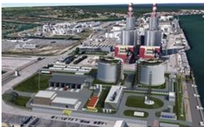
Figura 37. Progetto PIR e Edison nel porto di Ravenna
