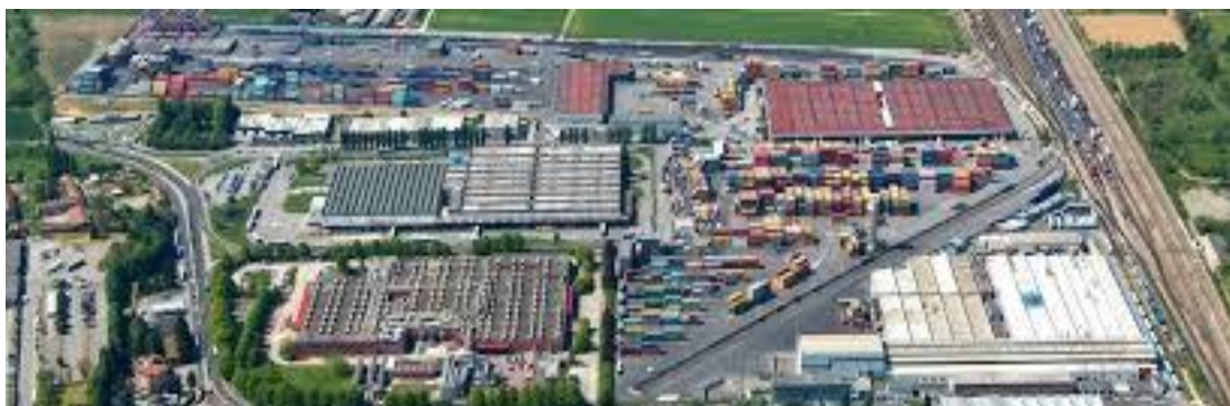
Figura 25. Terminal intermodale di Melzo
