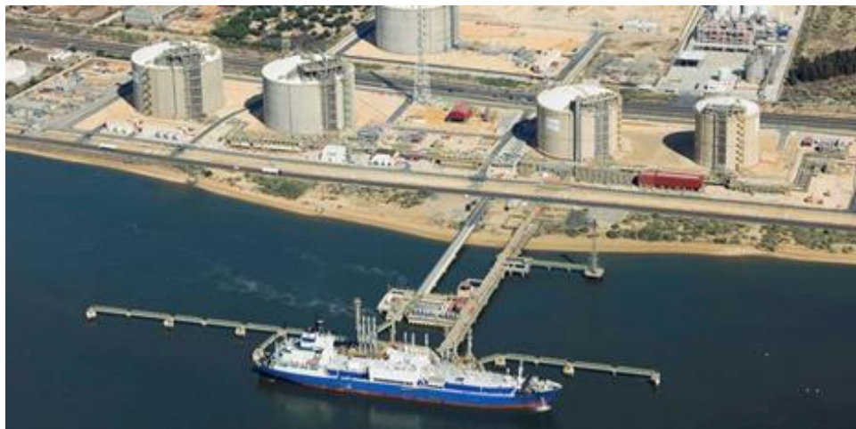
Figura 52. Terminal de Huelva
