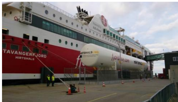
Figura 5-16: Impianto di bunkeraggio con serbatoio di stoccaggio fisso (porto di Hirtshals, in Danimarca, per Fjord Line)
