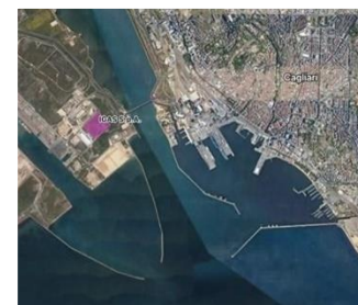
Deposito GNL nel Porto di Cagliari
