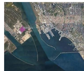
Deposito GNL nel Porto di Cagliari
