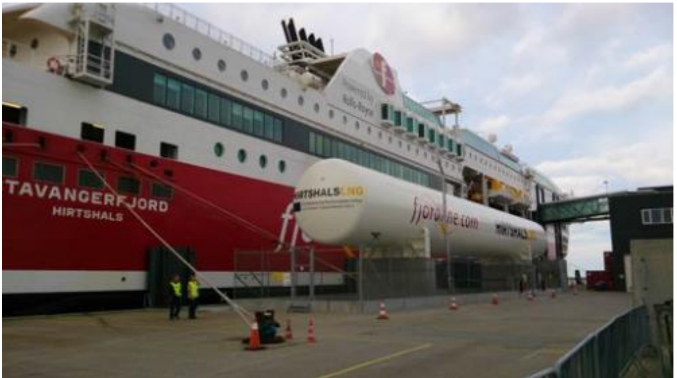
Figura 48 - Impianto di bunkeraggio con serbatoio di stoccaggio fisso (porto di Hirtshals, in Danimarca, per Fjord Line)
