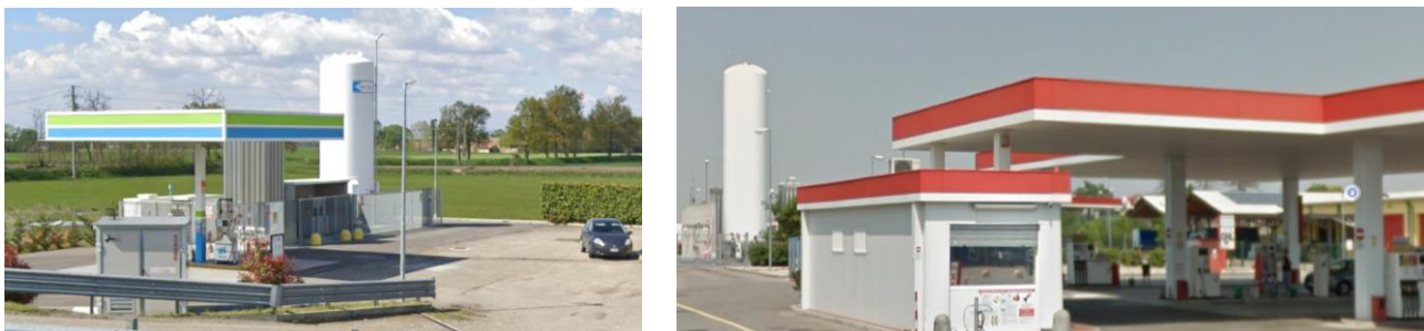
Figura 13: Serbatoio GNL Voghera e Tortona
