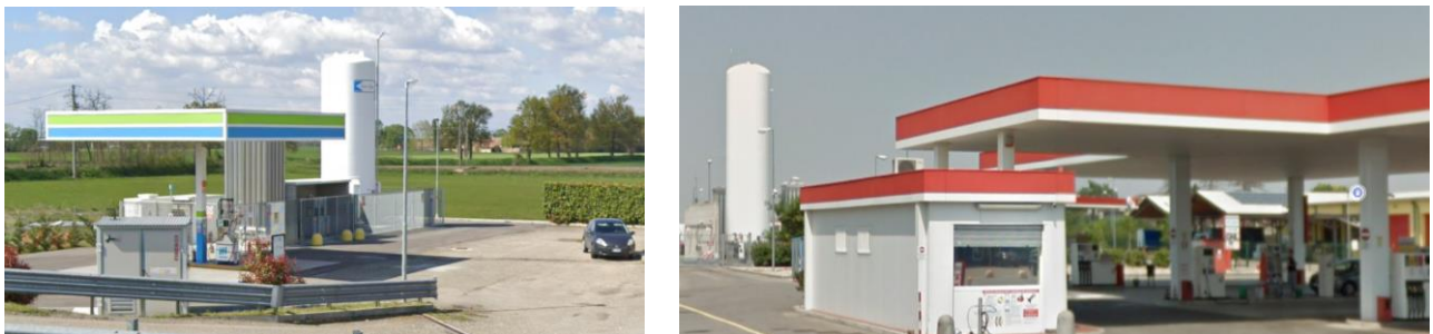
Figure 13: Réservoir GNL Voghera et Tortona
