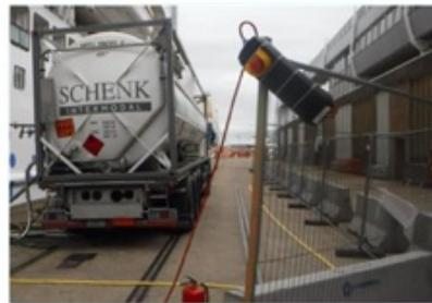
Commande « push button » de déclenchement ESD et détecteur de présence de gaz
