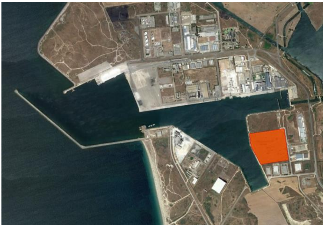
Figura 2 Localizzazione dell'impianto Edison nel porto di Oristano
