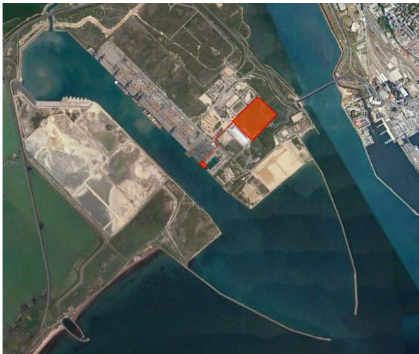
Figura.1 Localizzazione dell'impianto ISGAS nel porto canale di Cagliari
