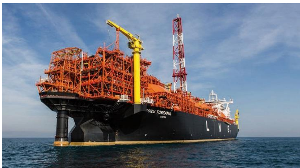
Figura 24: Impianto FSRU OLT Offshore LNG Toscana
