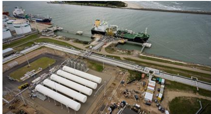
Figura 36: Vista aerea della stazione di GNL di Klaipeda
