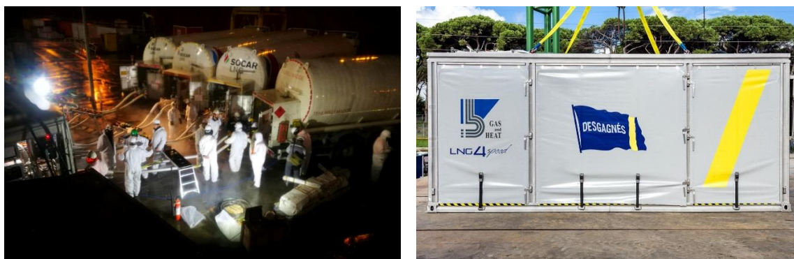
Figura 55: Operazioni di bunkering in fase di collaudo dello skid (sinistra) e unità riassemblata pronta per il trasporto come container da 20 piedi (destra) di Gas&Heat
