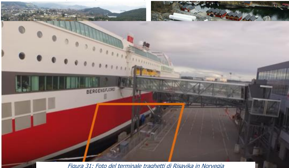
Figura 31: Foto del terminale traghetti di Risavika in Norvegia
