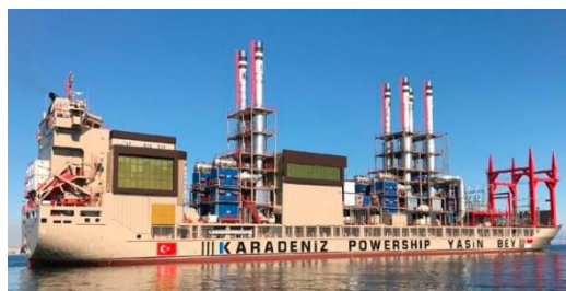
Figura 23: Una delle 17 navi-centrali elettriche di Karpower leader del settore
