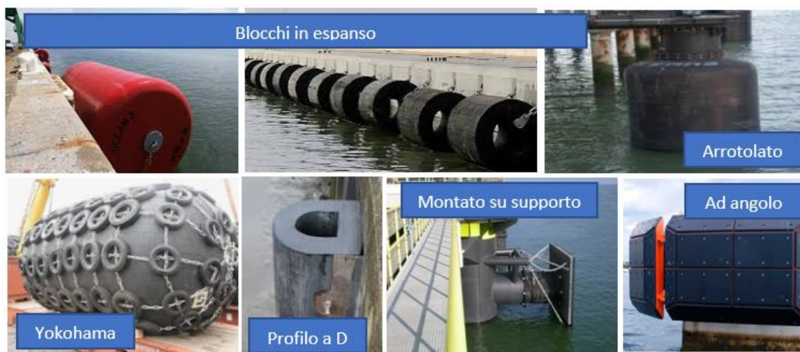
Figura 5: Esempi di parabordi di accosto
