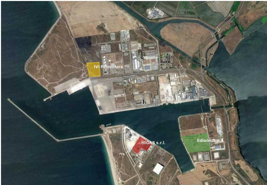
Figura 8: Depositi GNL nel Porto di Oristano
