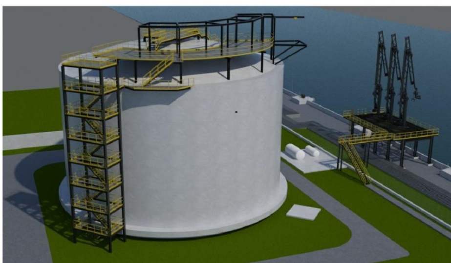
Figura 2 – Serbatoio stoccaggio GNL e bracci di carico
