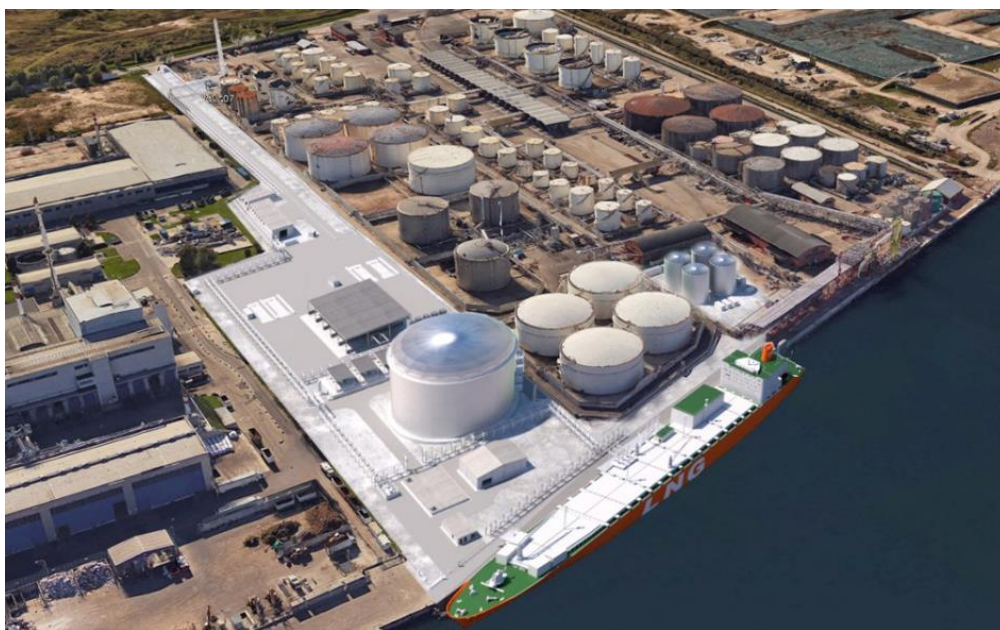
Figura 94 - Il Rendering del deposito costiero GNL del terminale di Venezia (Fonte: Venice LNG)
