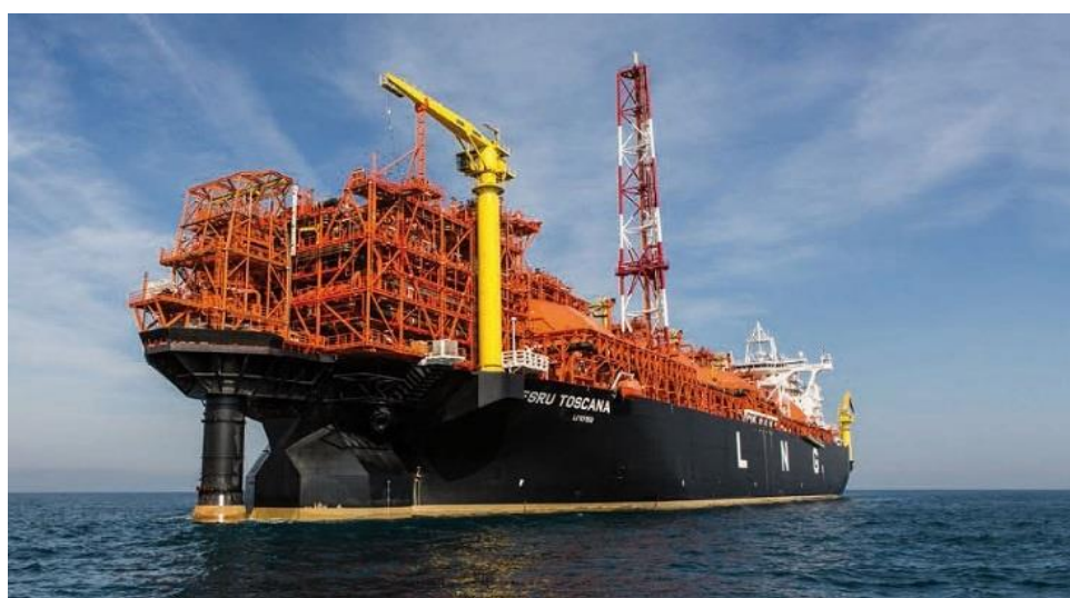
Figura 86 - Impianto FSRU OLT Offshore LNG Toscana (Fonte: OLT Offshore)
