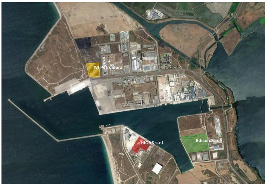
Figura 88 - Depositi GNL nel Porto di Oristano
