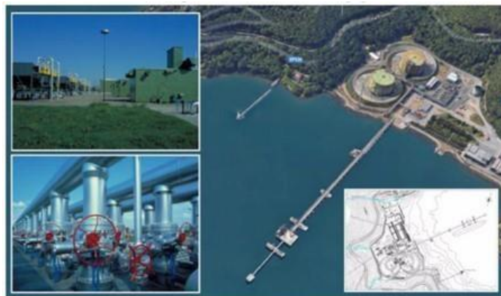
Figure 85 - Terminal de regazéification de Panigaglia
