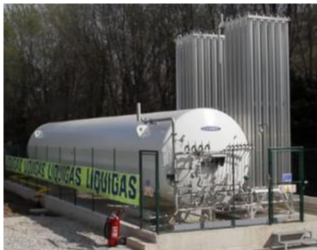
Figure 21 - Réservoir cryogénique et vaporisateur (Source: Luce-Gas.it)
