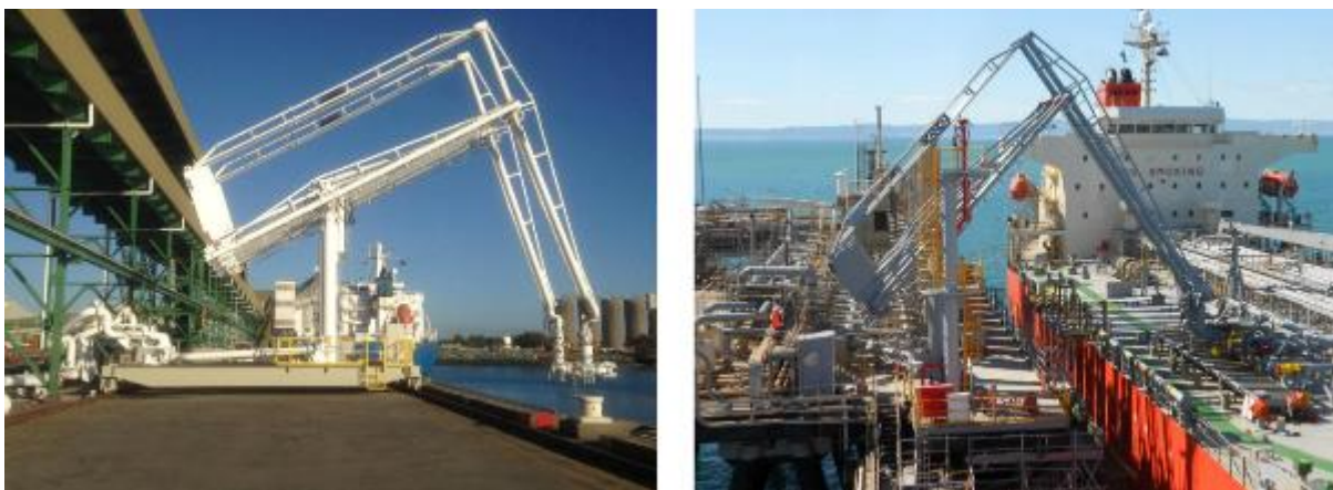
Figure 54 - Bras typiques de chargement/déchargement de GNL au quai (Source: Kanon technologies)
