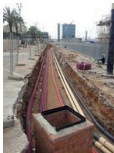
**Fig. 5 – Port Vell à Barcelone: un port équipé d'un système d'aspiration canalisée (Source: site internet <https://flovac.es/en/projects/marinas-and-port-facilities/>)**
