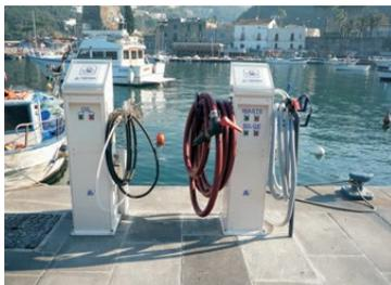
**Fig. 4 – Colonne d'aspiration d'eau de cale (Source: site web <https://www.sistemamarine.it/aspirazione-reflui-2/>)**
