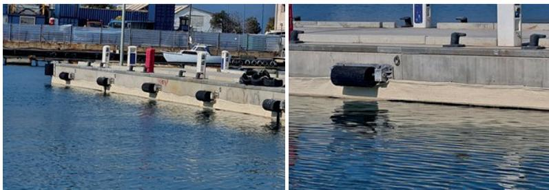
**Fig. 17. Panneaux en laine de mouton positionnés sur un quai fixe (les panneaux Geolana® ont été fournis par Industries Edizero et installés dans le Port de Cagliari dans le cadre du projet GRRinPORT)**
