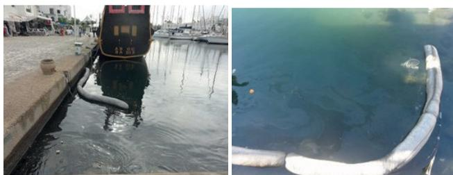
**Fig. 16. Barrages en liège traité thermiquement (des barrages CorkSorb® ont été fournis par Amorim et installés dans la Marine d'El Kantaoui dans le cadre du projet MAPMED)**
