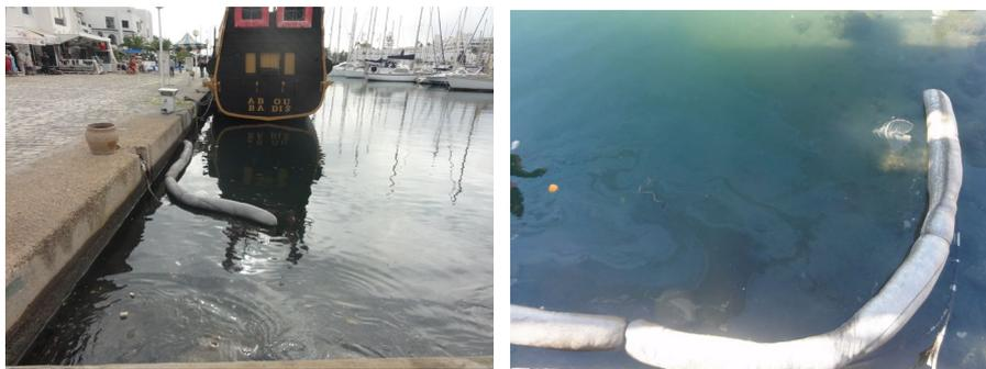
Fig. 16. Barrages en liège traité thermiquement (des barrages CorkSorb® ont été fournis par Amorim et installés dans la Marine d'El Kantaoui dans le cadre du projet MAPMED).
