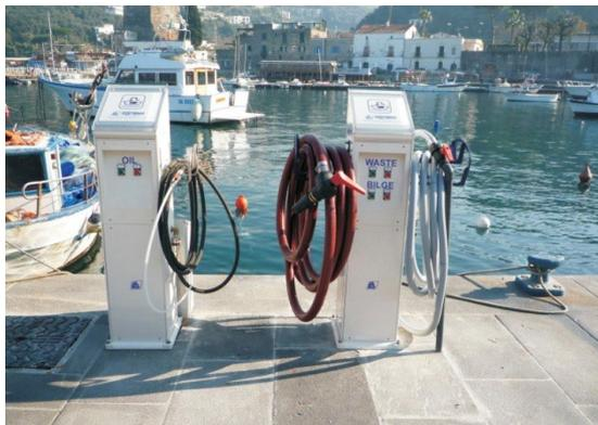
Fig. 4 – Colonne d'aspiration d'eau de cale (Source: site web <https://www.sistemamarine.it/aspirazione-reflui-2/>)
