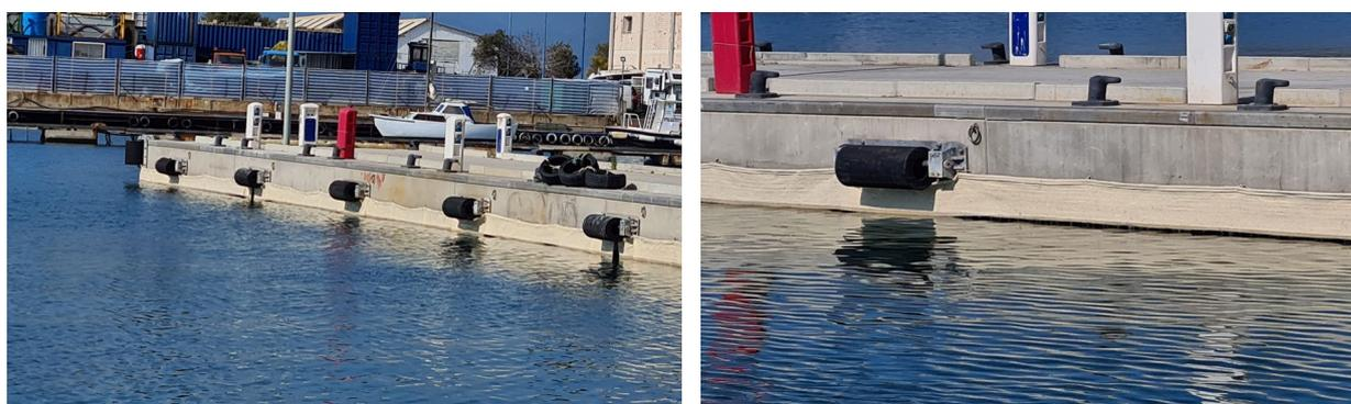
Fig. 17. Pannelli in lana di pecora posizionati su banchina fissa (i pannelli Geolana® sono stati forniti da Industrie Edizero e installati nel Porto di Cagliari nell'ambito del progetto GRRinPORT).
