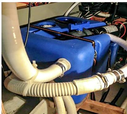
Fig. 7 - Particolare di un kit per il recupero dei reflui con innesto standard al sistema di raccolta ed aspirazione
