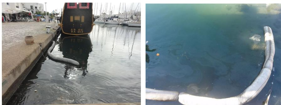
Fig. 16. Booms in sughero termotrattato (i booms CorkSorb® sono stati forniti da Amorim e installati nella Marina di El Kantaoui nell'ambito del progetto MAPMED).
