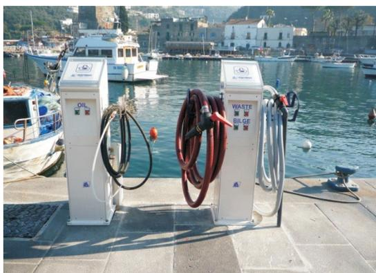
Fig. 4 – Colonnina di aspirazione di acque di sentina (Fonte: sito web <https://www.sistemamarine.it/aspirazione-reflui-2/>)
