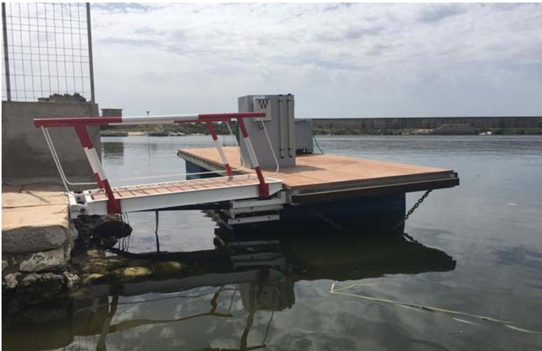
**Figure 2.** Zone équipée pour l'aspiration des eaux de cale dans le port de Cagliari
