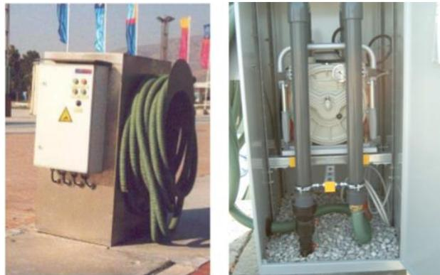
Figure 1. Colonne d'aspiration des déchets liquides et détail de la pompe péristaltique
