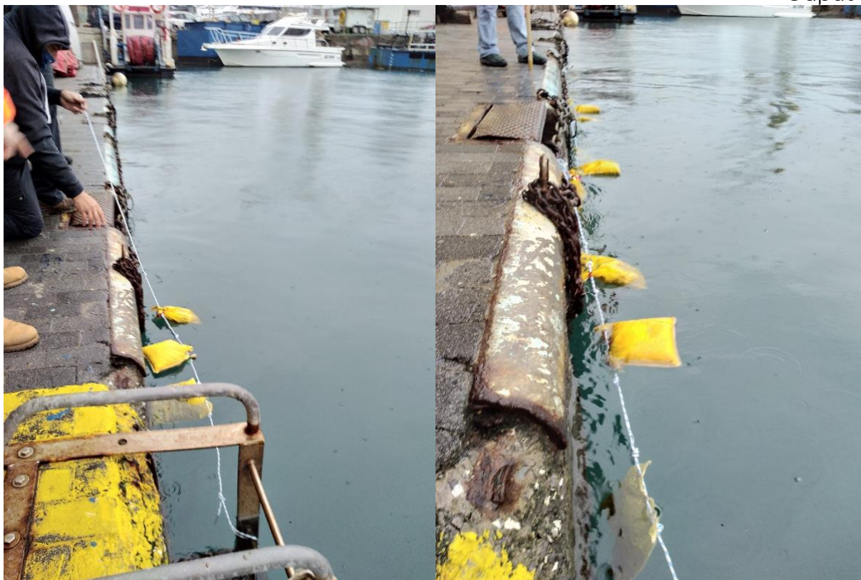
Fig. 2.3.8 - Fissaggio della cima con i cuscini alla banchina.
