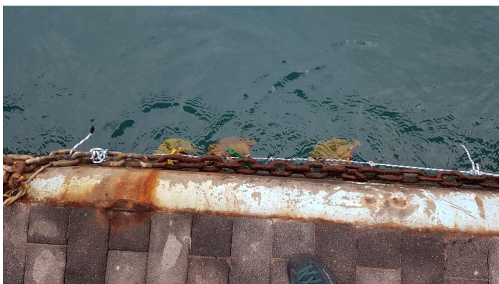
Fig. 2.3.12 – Inspection aux barrages.
