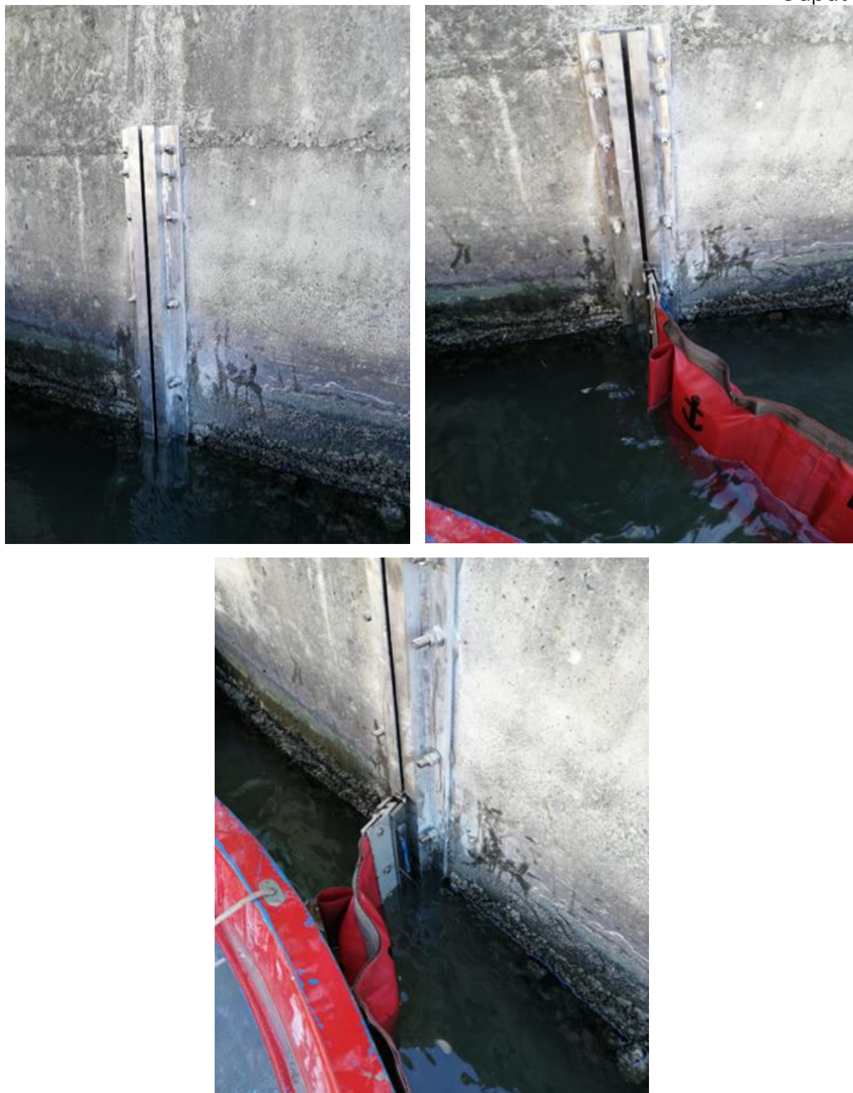
Figura 3.4 Dettaglio delle coulisse installate sui moli nel Canale di Sampierdarena.
