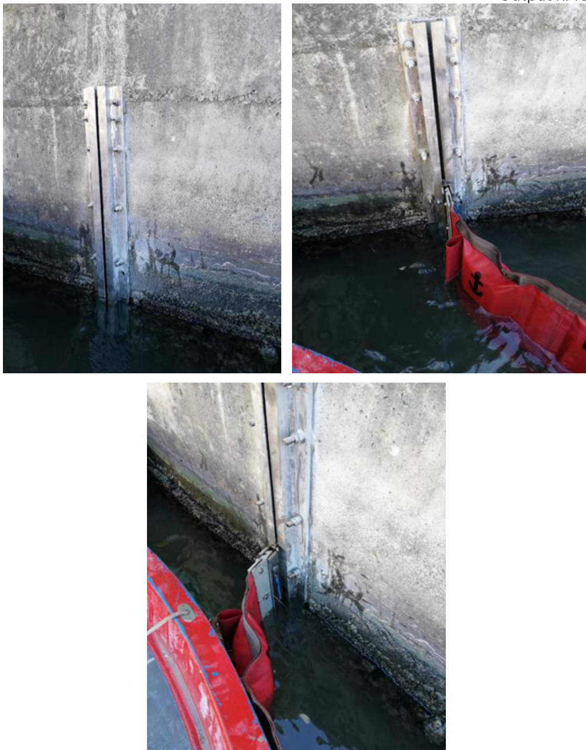
Fig. 3.4 Détail de la coulisse installée sur les quais dans le canal de Sampierdarena.
