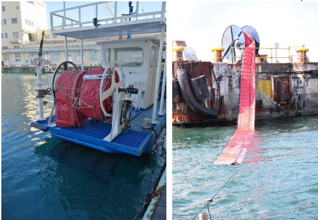
Figura 3.2 Panne installate su una imbarcazione (a sinistra) e dislocate su rulli su una banchina portuale (a destra).
