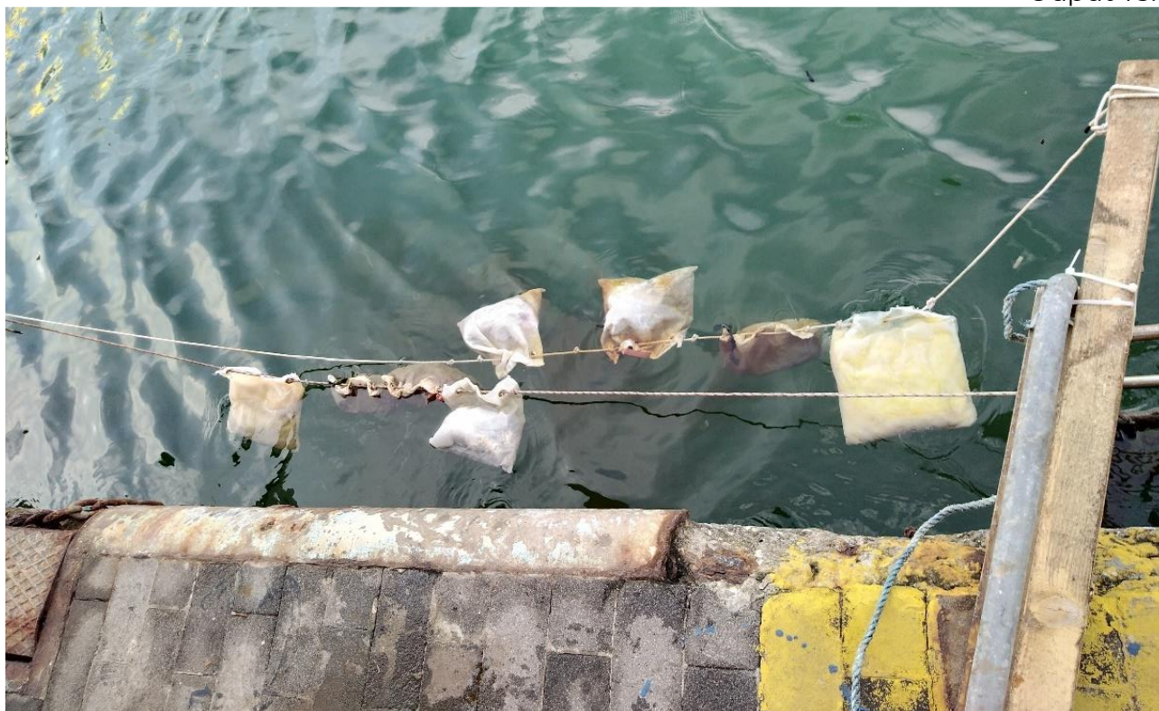
Fig. 2.3.24 - Installazione delle panne assorbenti.
