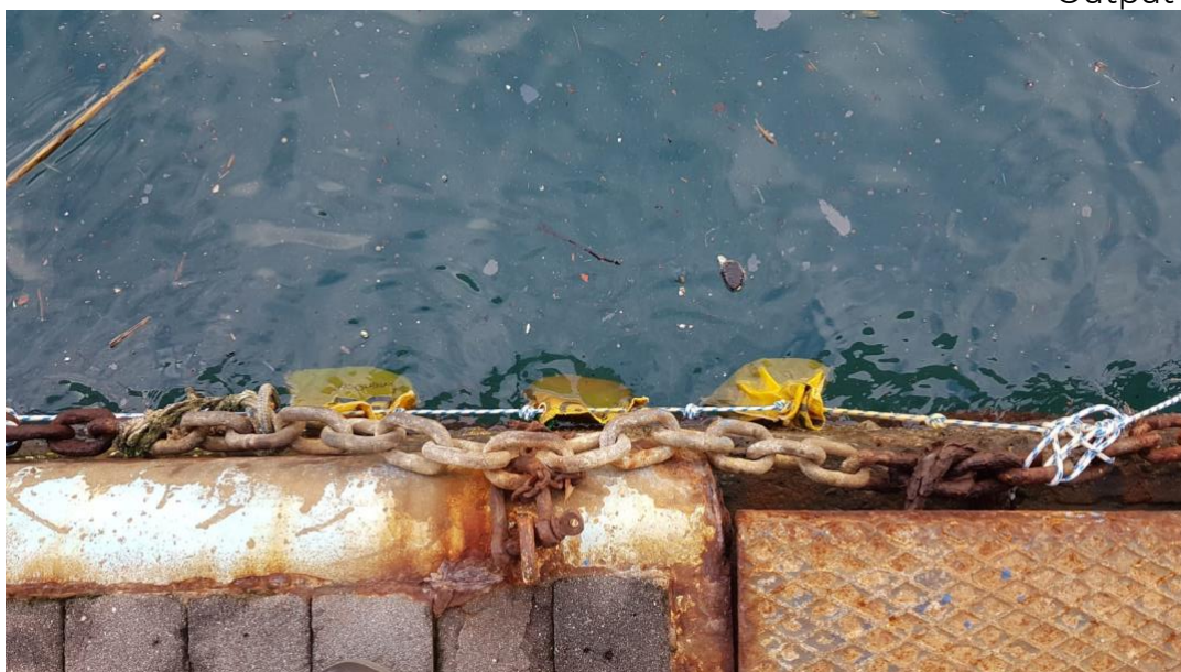
Fig. 2.3.15 – Inspection aux barrages.
