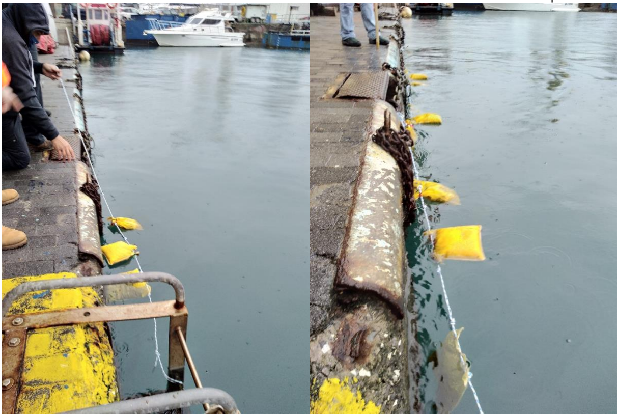
Fig. 2.3.8 - Fixation de la ligne avec barrages au quai.
