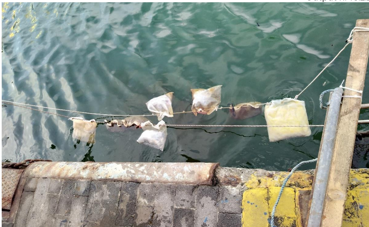
Fig. 2.3.24 – Installation des barrages absorbants.
