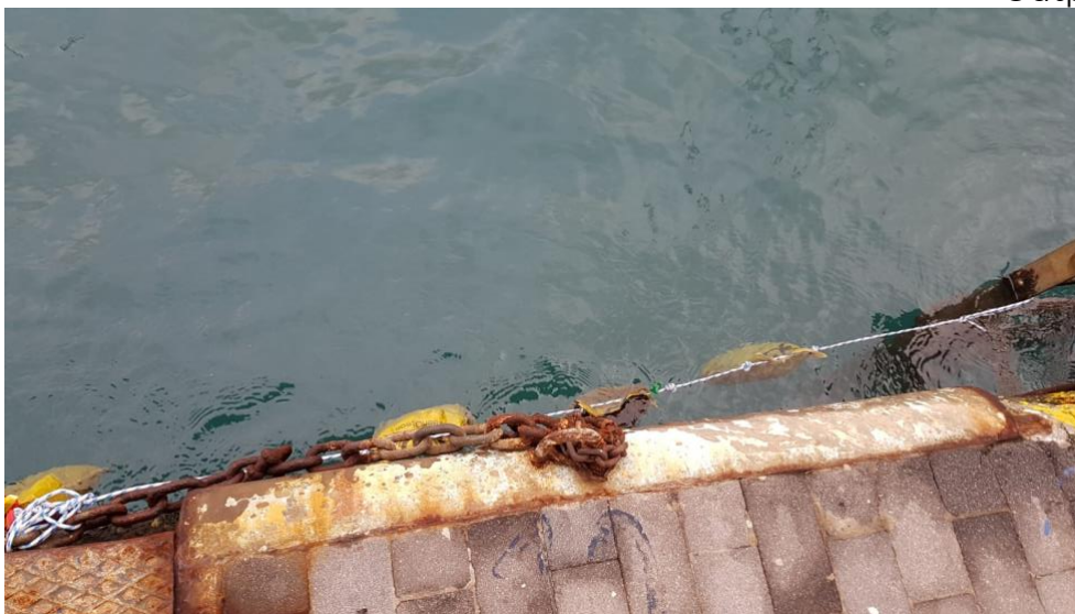
Fig. 2.3.13 – Inspection aux barrages.
