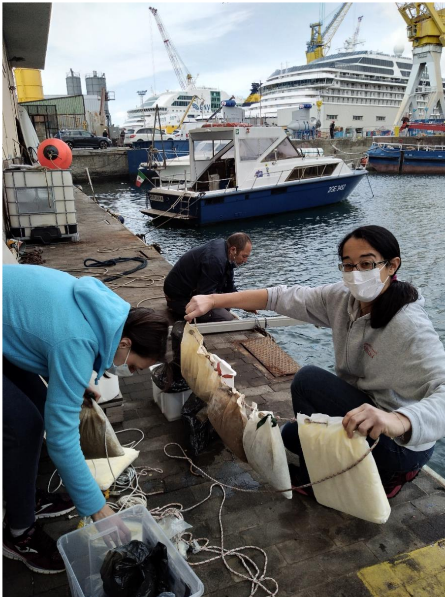
Fig. 2.3.23 – Installation des barrages absorbants.
