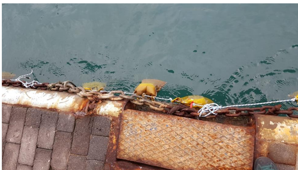
Fig. 2.3.11 – Inspection aux barrages.
