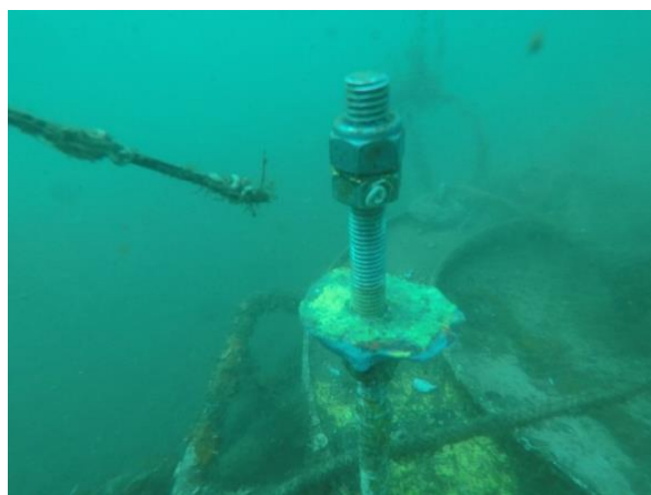
Fig. 8. La flangia con l'anodo di zinco consumato ad aprile 2021 / La bride avec l'anode en zinc en avril 2021.
