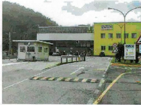
Occhiali elettronici agli accessi di Easylog interporto Vio
