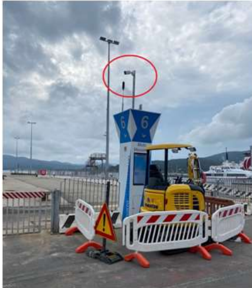
Figura 18: Sensore per il monitoraggio delle persone presso i moli di imbarco e sbarco.
