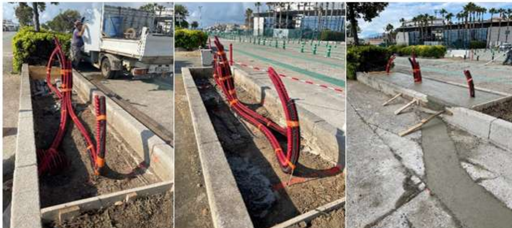
Figura 28: Lavori stradali eseguiti.
