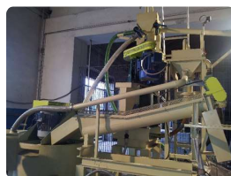
Omogeneizzazione della miscela, all'interno della pompa di rilancio e avvio al corpo separatore centrale
