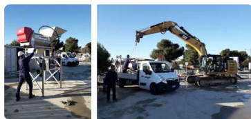
Fasi di allestimento dell'area di trattamento
