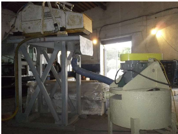
Foto 2- Vibrovaglio e pompa di omogeneizzazione
