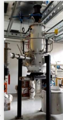
Pilote de gazéification GASCLEAN
