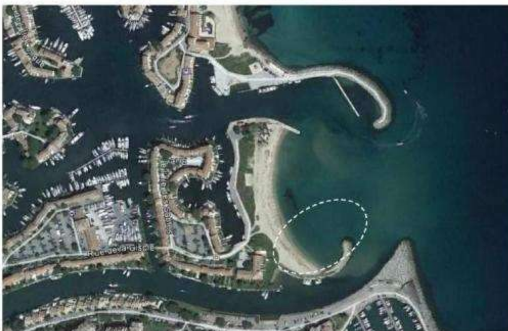
Figure 15 : Photos aériennes historiques de 2016 (source GoogleEarth)
