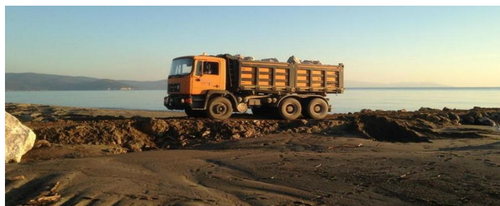
Figure 3. Une phase des travaux.
