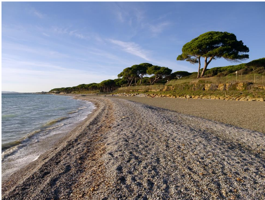
Illustration 8. Matériaux de rechargement en graviers sur la plage de Pratoranieri (novembre 2017)
