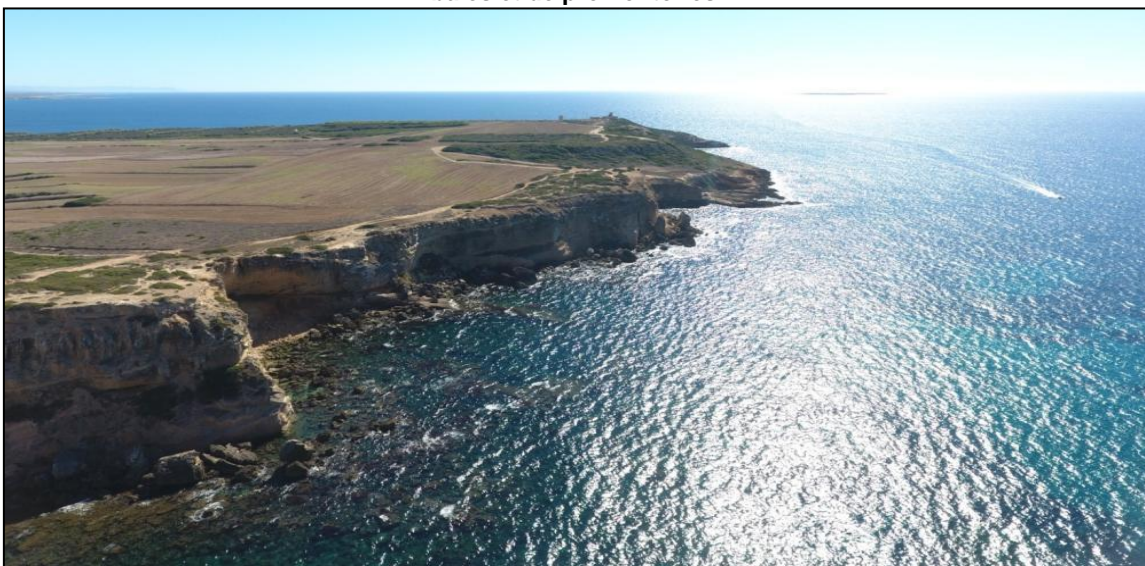
Illustration 9 - Zone côtière entre Torre di Capo Mannu et Capo Mannu ; en évidence, l'effondrement se dépose à la base des rochers.
