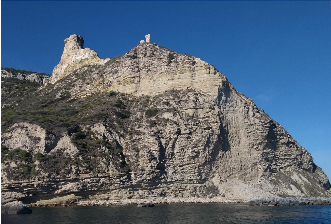
Illustration 11 – Coupe de la falaise du promontoire de Sella del Diavolo , sous la Torre del Poetto , plusieurs fois le site de l'activité de glissement de terrain de 1987 à 2017, on note l'accumulation de glissements de terrain au pied de la falaise et la surface le long du détachement.
