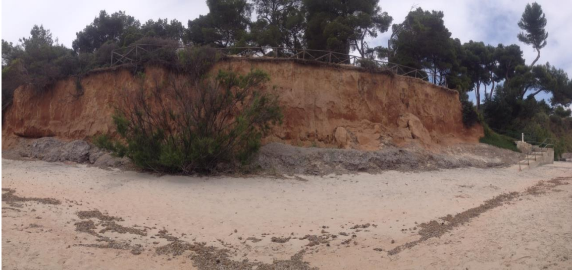
Illustration 15 - Est-Morus village résidentiel D'autres dommages structurels à la clôture qui délimite la structure touristique.
