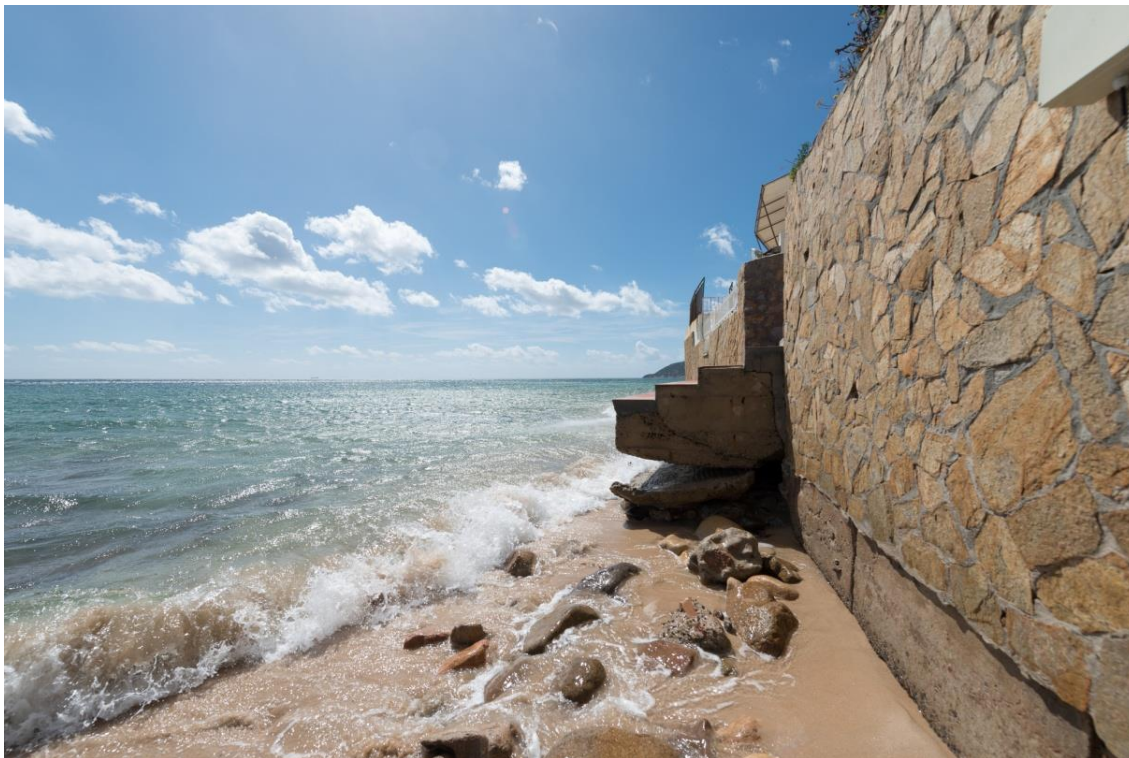
Illustration 11 – Resort di Forte Village - La Swash zone interessa la struttura muraria in quanto l'assetto di spiaggia è privo di berma. La conllustrationzione del manufatto è precaria
