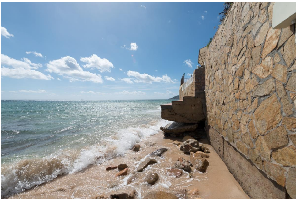
Figura 11 – Resort di Forte Village - La Swash zone interessa la struttura muraria in quanto l'assetto di spiaggia è privo di berma. La configurazione del manufatto è precaria
