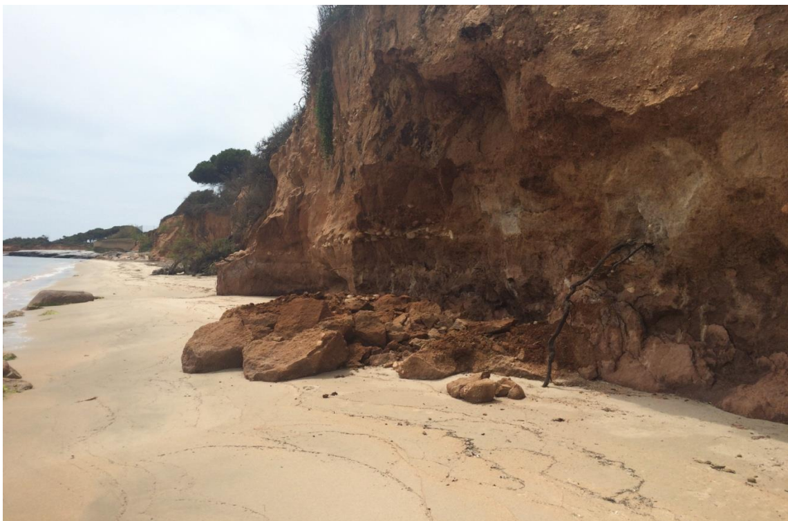
Figura 8 – Località Is Morus. Fenomeni di crollo sulla ripa rocciosa.
