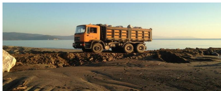
Figura 3. Una fase dei lavori.
