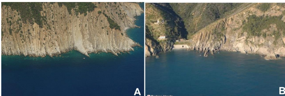
Figura 2 – Falesia attiva presso Punta Baffe (A) e esempi di fenomeni franosi per scivolamento planare (B) (da Regione Liguria, foto prospettiche della costa 2010)
