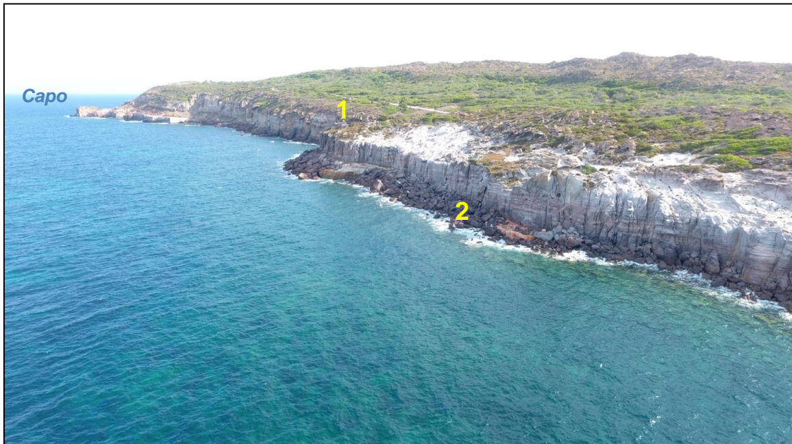
Figura 9 – Settore litorale a sud di Capo Altano. 1) Ciglio della falesia;2) Depositi di frana al piede della falesia.
