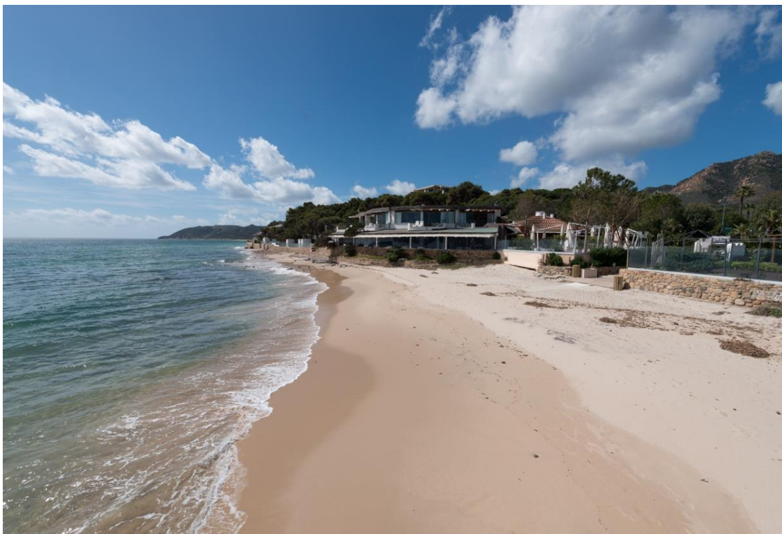
Figura 9 – Resort di Forte Village - Foto del 19/03/2018. Inizio tratto a massimo dissesto. Foto da Nord Est verso SudOvest
