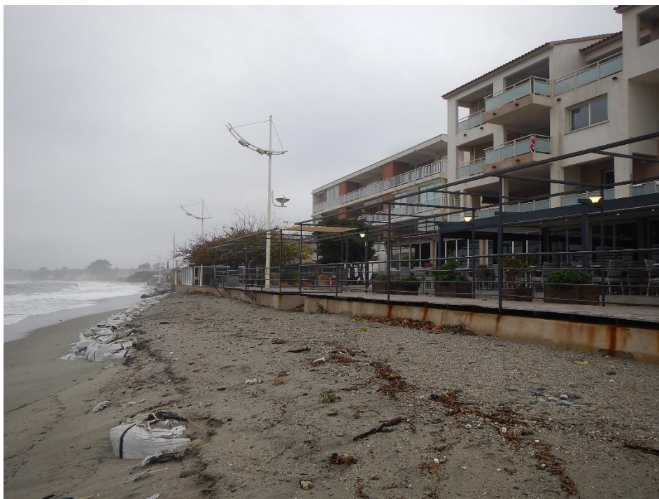
Figura 6 – Esempi di attività vulnerabili all'erosione costiera sul sito di Moriani (17/12/2017).
