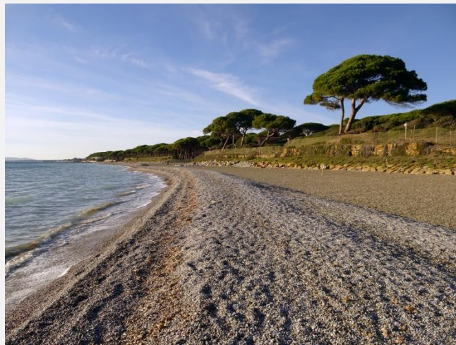
Figura 8. Il ripascimento in ghiaia sulla spiaggia di Pratoranieri (Novembre 2017)
