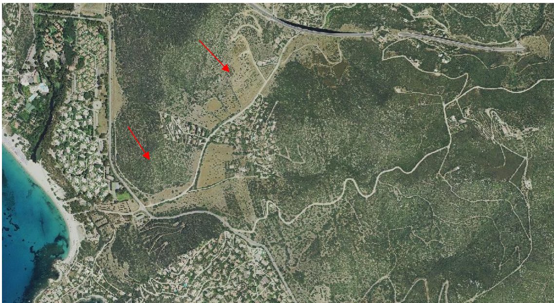
Figura 14 - Il tracciato del Rio Marroccu e del Rio S'acqua Mala nel 2016; entrambi completamente obliterati dalla sede stradale.
