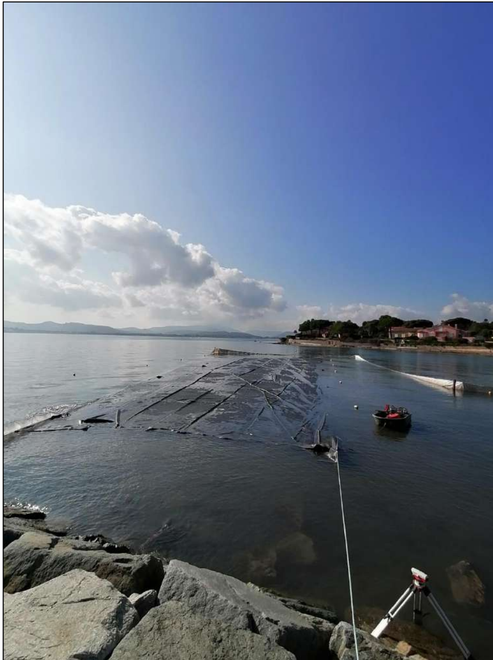
Illustration 13 - Mise en place du tapis anti-affouillement en géotextile
