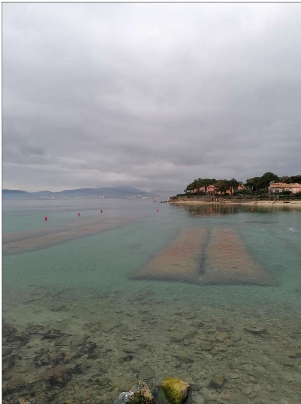
Illustration 14 - Photo réalisée en février 2020 illustrant les géotubes en place, visibles par transparence de l'eau
