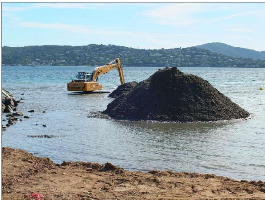
Illustrazione 9 - Sabbia scaricata dalla zona di posizionamento durante le operazioni di sterro
