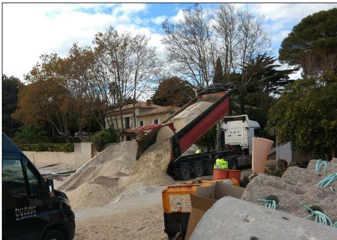
Illustration 12 - Livraison du sable de remplissage sur la zone de chantier
