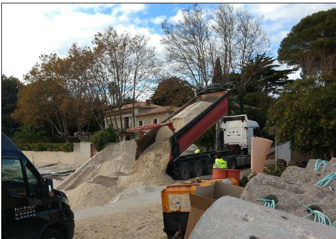
Illustrazione 12 - Consegna della sabbia di riempimento nella zona di cantiere
