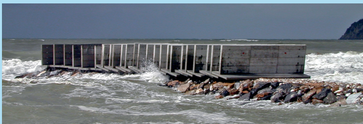
Figura 5.6. Elementi prefabbricati per la costruzione dei setti sommersi pronti per essere messi in opera (Febbraio 2005).
