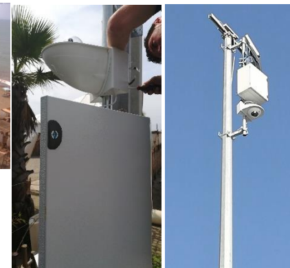
Installazione di Webcam per la calibrazione/validazione di modelli
