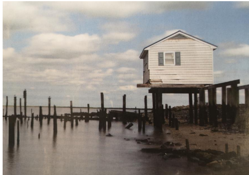
Casa in attesa di demolizione nel New Jersey (le Scienze, dicembre 2018)
