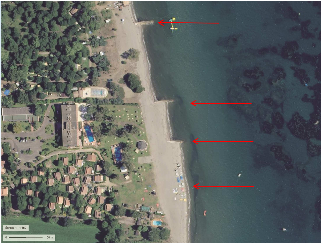
Protection du trait de côte par la mise en œuvre 5 géotubes (CD2b – 2008)
