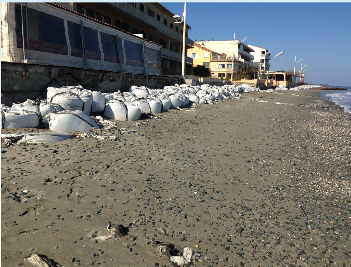
Mise en œuvre d'épis de protection en bigbag (2014)
