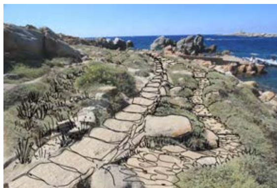
Ripristino del muro di sostegno a monte del sentiero e miglioramento del layout.
