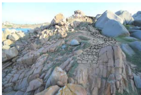
La calade existante est confortée, complétée, et prolongée pour limiter le ravinement, matérialiser le cheminement et canaliser le public.
