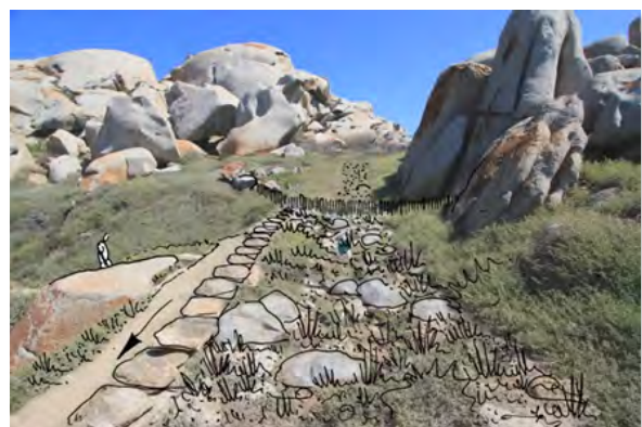
ETAT PROJETE : Décompactage de la surcharge de sentier, installation de ganivelles pour fermeture de l'accès public au phare (accès de service uniquement).
