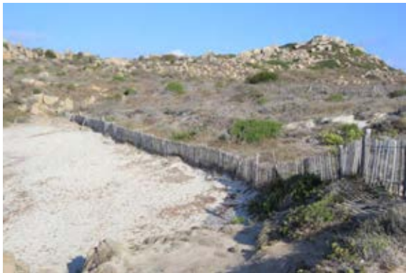
STATO ATTUALE: ganivelles già installati, alcuni devono essere sostituiti e altri devono essere rimossi (perpendicolare alla linea di costa).
