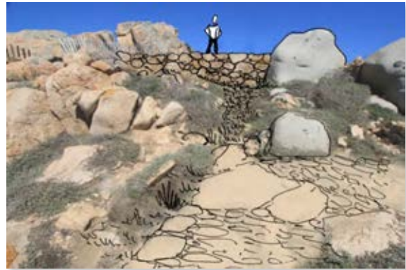
Da valle: il muro di sostegno è perfettamente integrato nei blocchi di roccia esistenti.
