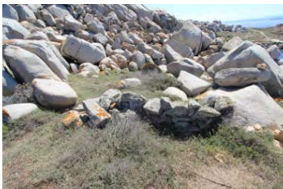
ETAT ACTUEL : Ancien muret partiellement effondré.
