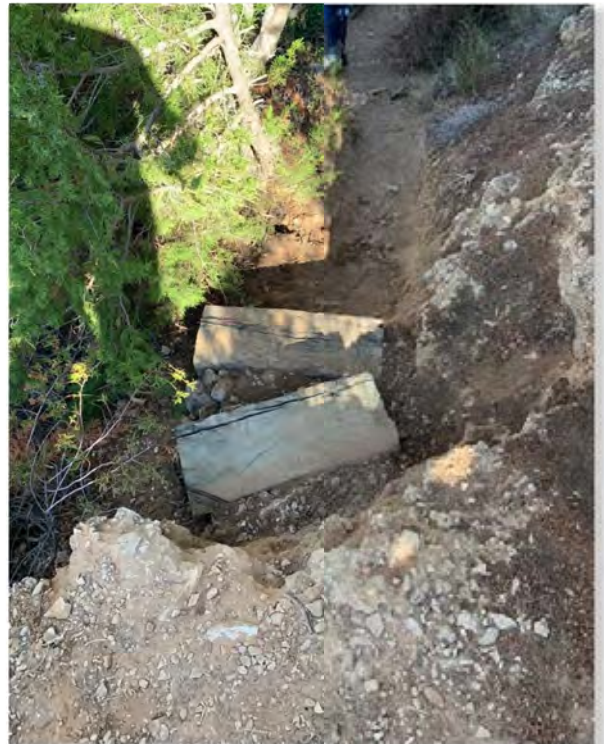
Figura 17 - 18: gradinata da campo e stabilizzazione terreno
