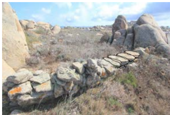
Restauration des couronnements des murets de clôture.
