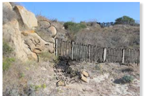
Prolungamento delle ganivelle parallele alla linea di costa e rinaturalizzazione del piccolo accesso settentrionale alla spiaggia.
