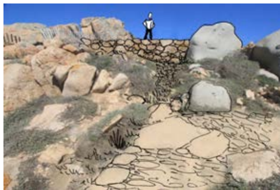
Depuis l'aval : le mur de soutènement est parfaitement intégrer aux blocs rocheux existants.
