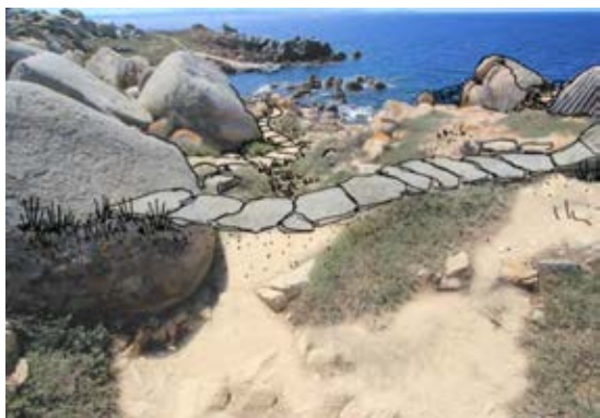
Depuis l'amont : mur de soutènement de la plateforme belvédère et fermeture de la trace actuelle (au col).
