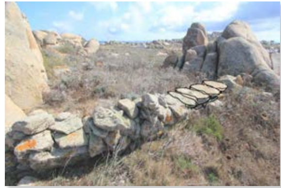
Restauro della sommità dei muretti.
