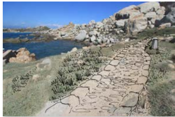
ETAT PROJETE : Calade traditionnelle marquant le cheminement public, dépose des panneaux, purge des traces de béton et cicatrisation.
