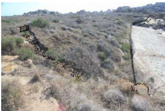
Prolungamento delle ganivelle parallele alla linea di costa e rinaturalizzazione del piccolo accesso settentrionale alla spiaggia.
