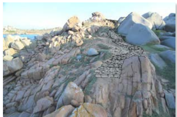
La calata esistente viene rafforzata, completata ed estesa per limitare il calpestio, pavimentare il percorso e incanalare il pubblico.
