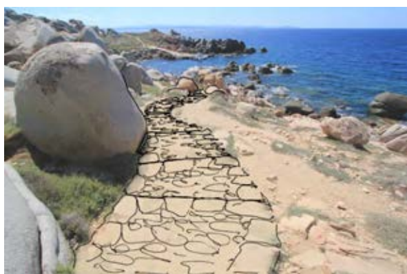
La calade existante est confortée, complétée, et prolongée pour limiter le ravinement, matérialiser le cheminement et canaliser le public.
