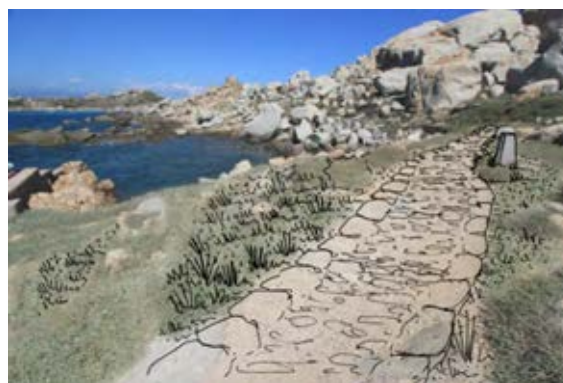
STATO DI PROGETTO: sentiero tradizionale che segna il percorso pubblico, rimozione dei pannelli, eliminazione delle tracce di cemento e rinaturalizzazione.
