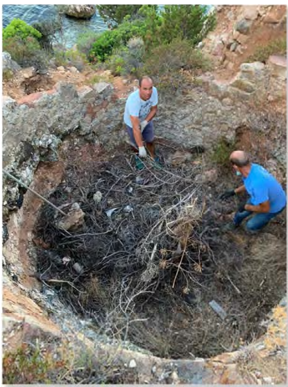
Figura 13 - 14: ripulitura e stabilizzazione, sterpaglie e masse terrose e/o rocciose poco stabili
