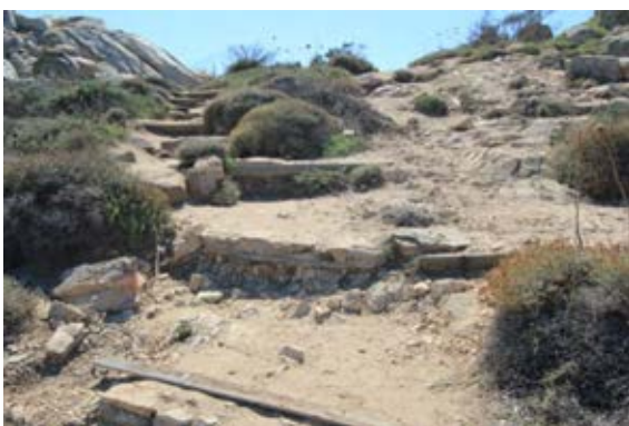
STATO ATTUALE: gradini irregolari, danneggiati e molto alti.
