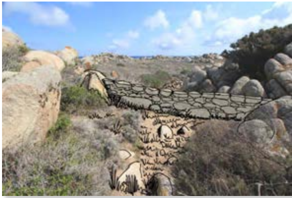
Realizzazione di un muretto tra due emergenze rocciose e rinaturalizzazione del vecchio sentiero che collega il cimitero di Furcone e Cala di u Lioni.
