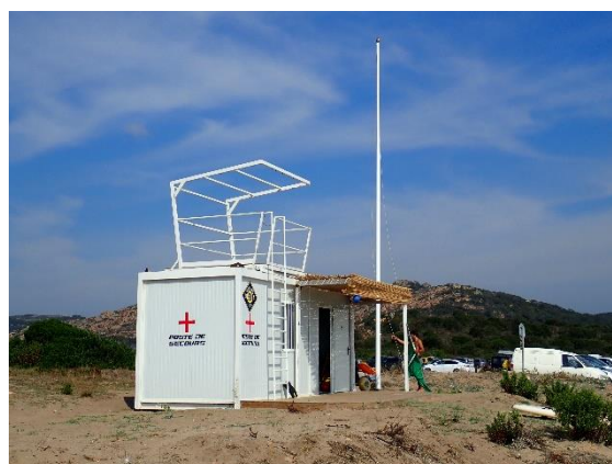
Figure 62 : Poste de secours au sud du parking
