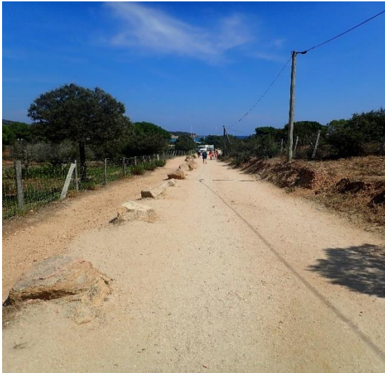
Figure 16 : Piste d'accès à la plage anciennement en sable et aujourd'hui goudronnée
