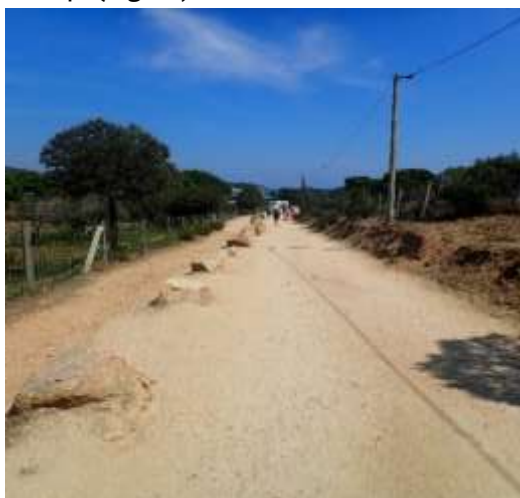
Figura 16: La strada di accesso alla spiaggia, un tempo sterrata, è oggi asfaltata
